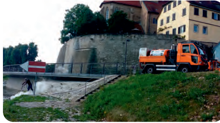
Wildkrautvernichtung in Kombination aus HD-Reinigung und ND-Gießanlage
